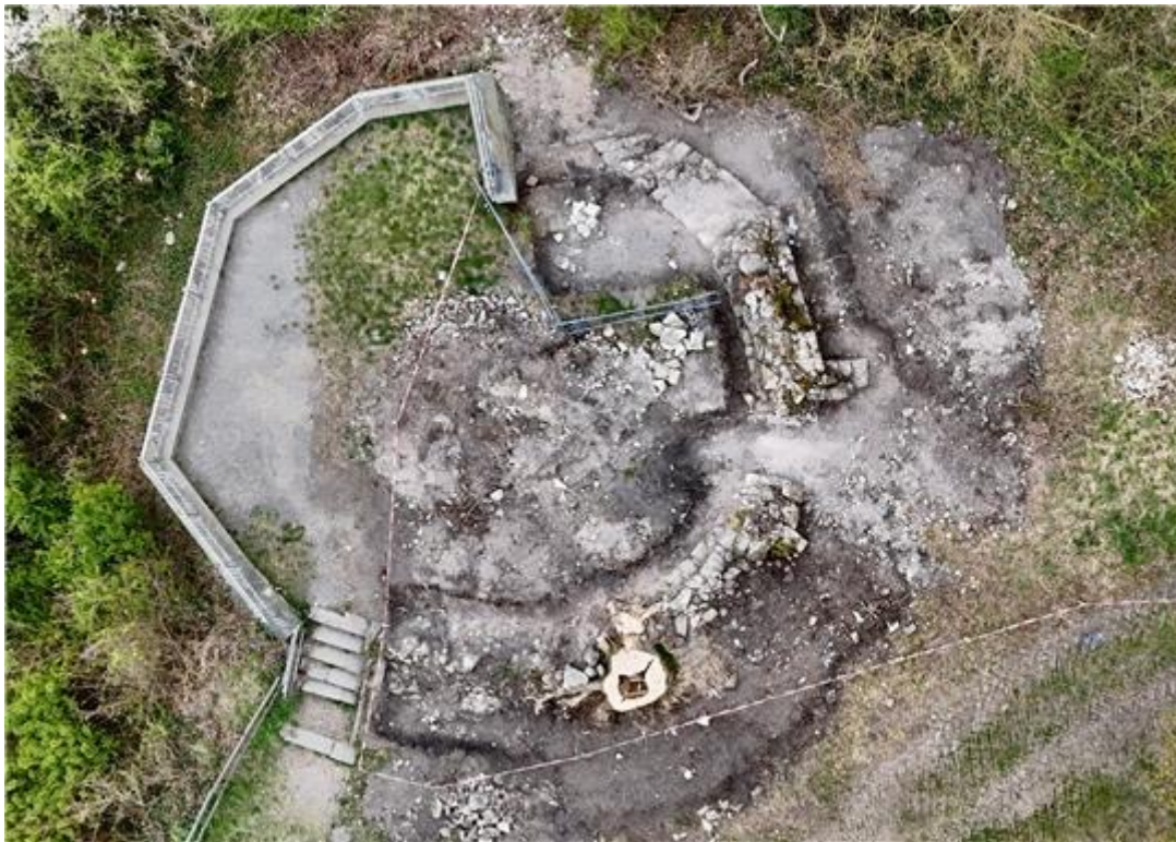
Erst aus der Luft zeigen sich während der Bauarbeiten die Ausmaße des Turms. Foto: Burgverein
